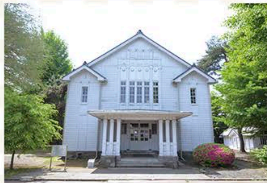
現在建物周りを工事中。(7月ごろ終了予定)
