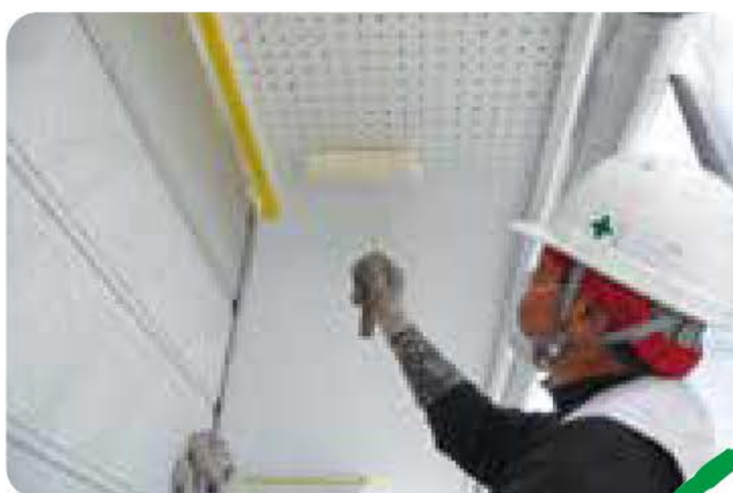
塗り替えの施工
