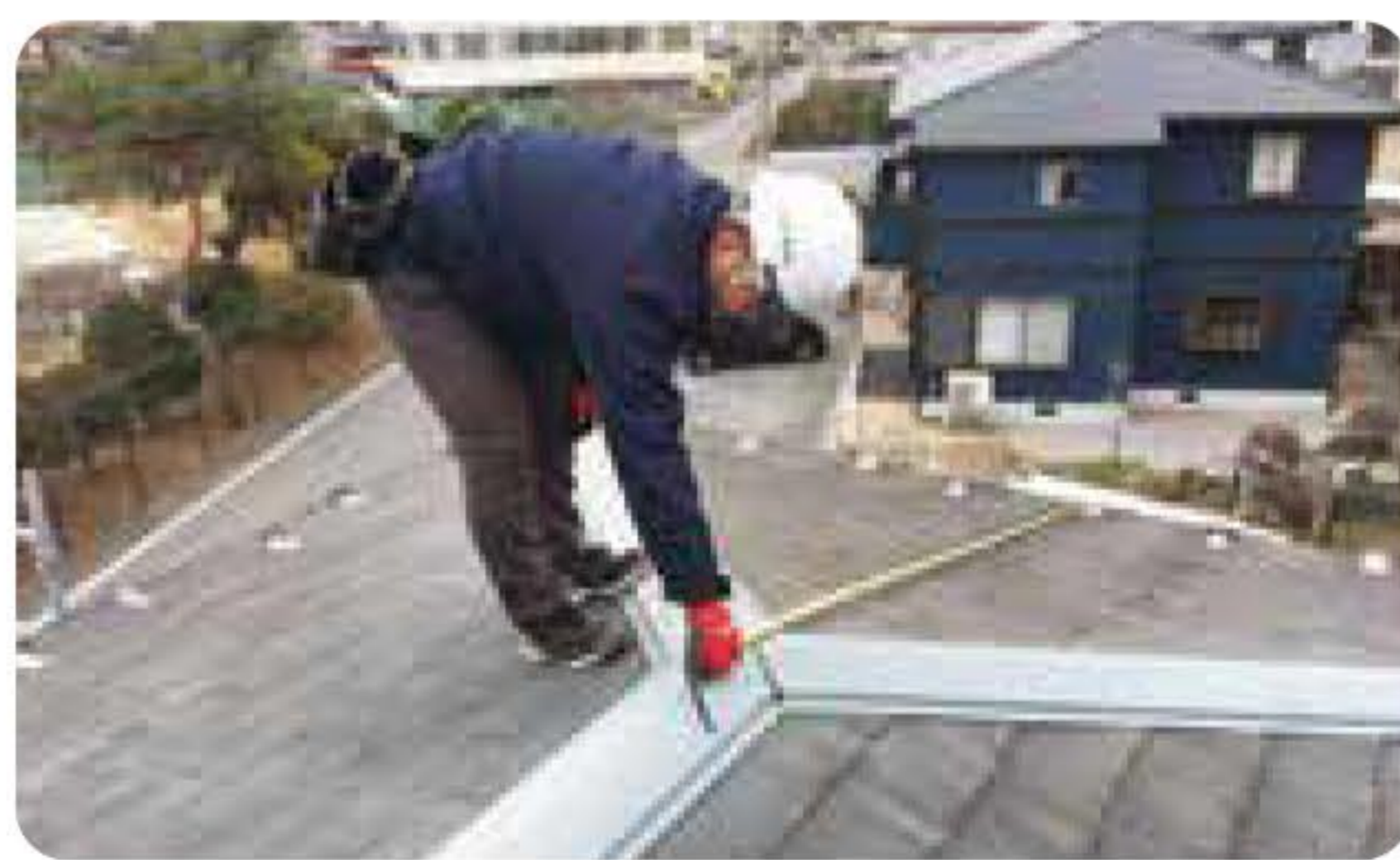
屋根の現場調査
